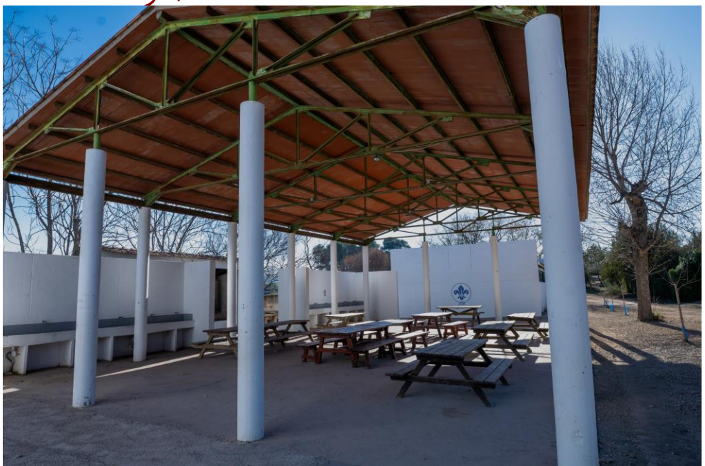
Casa Oràa. Menjador exterior
